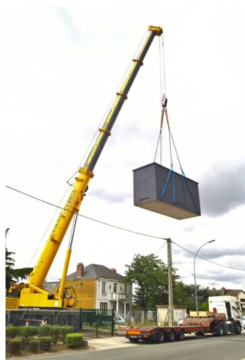
Installation du NRO de Vernouillet Juillet 2016
